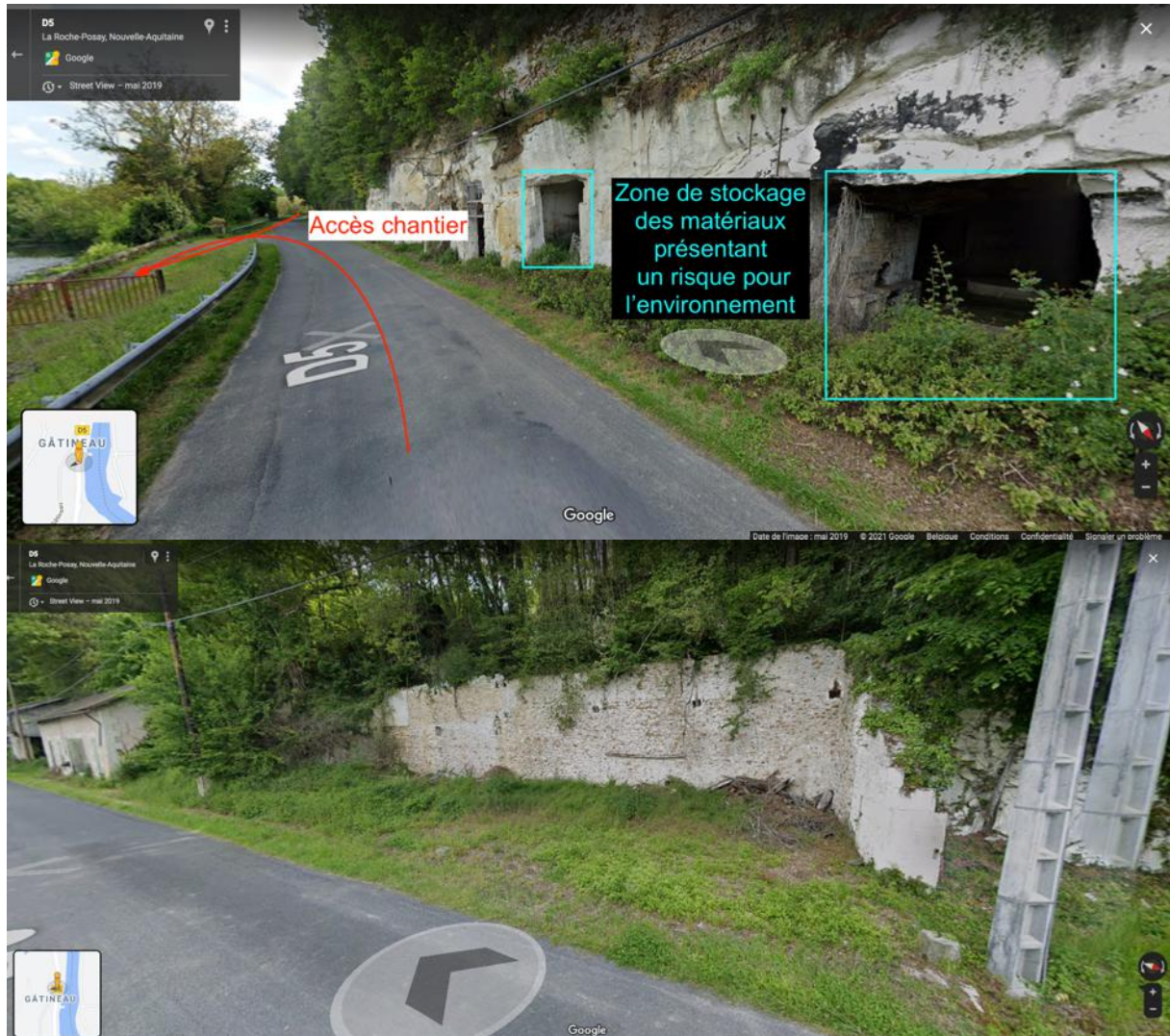
Figure 5 : organisation du chantier zones de stockage (streetview)
